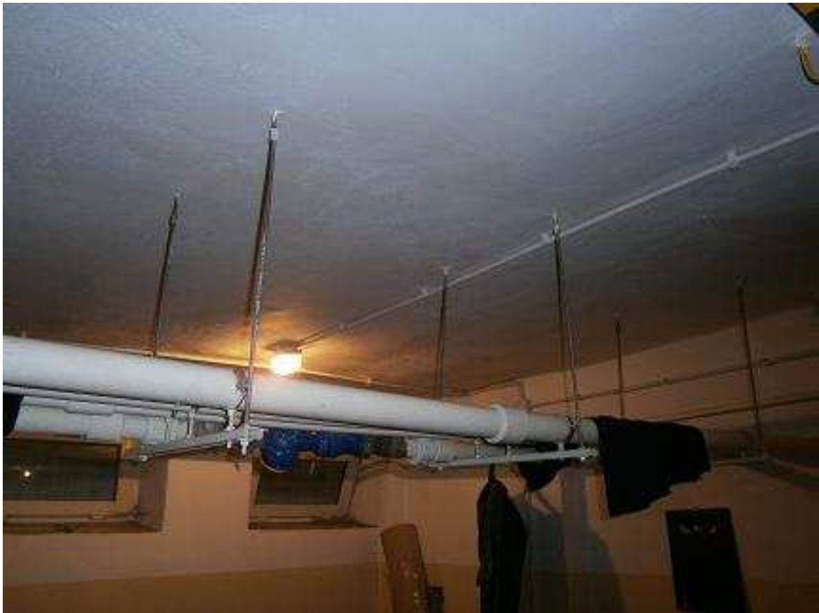
STROP W PIWNICY
