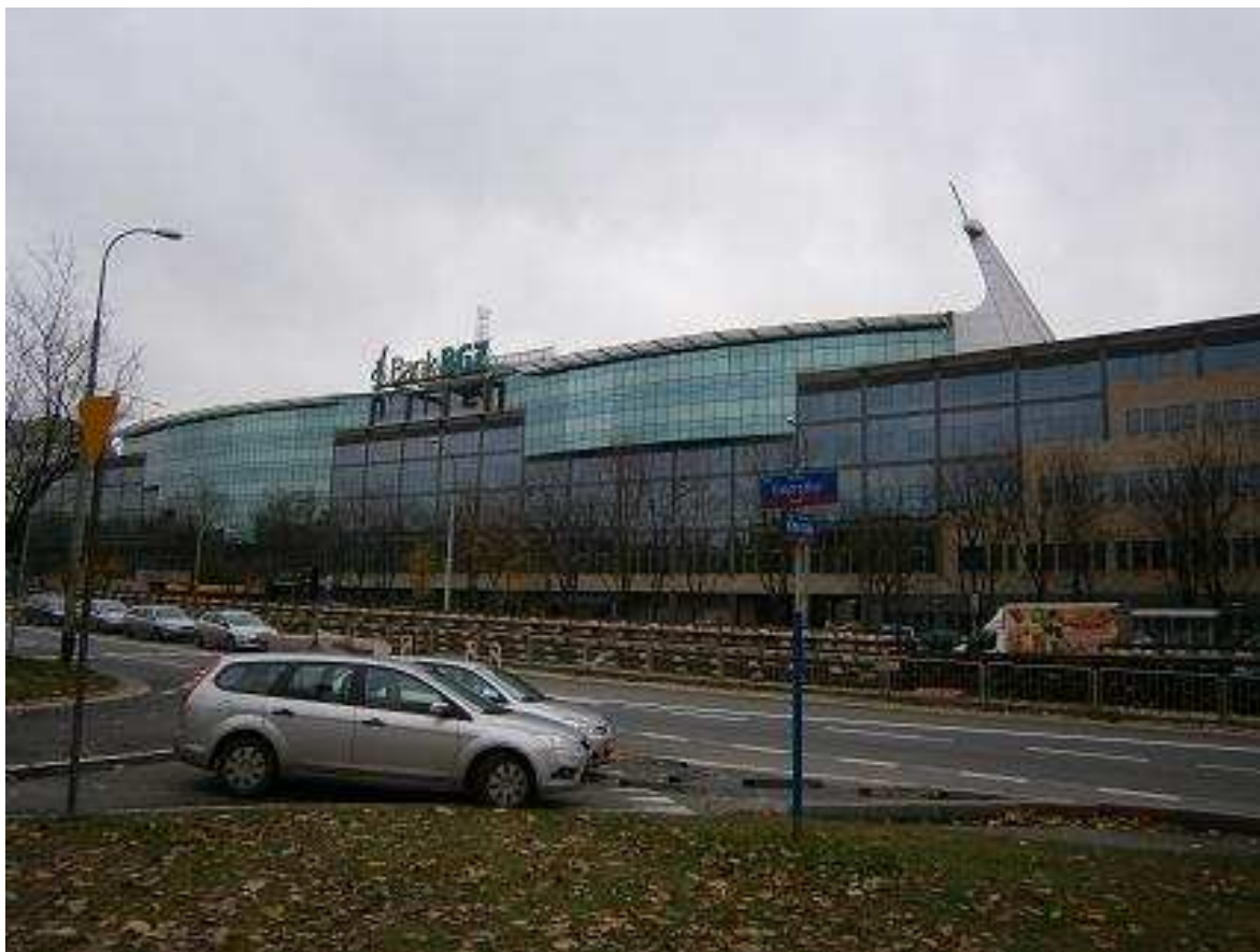
ELEWACJA OD STRONY ULICY KASPRZAKA
