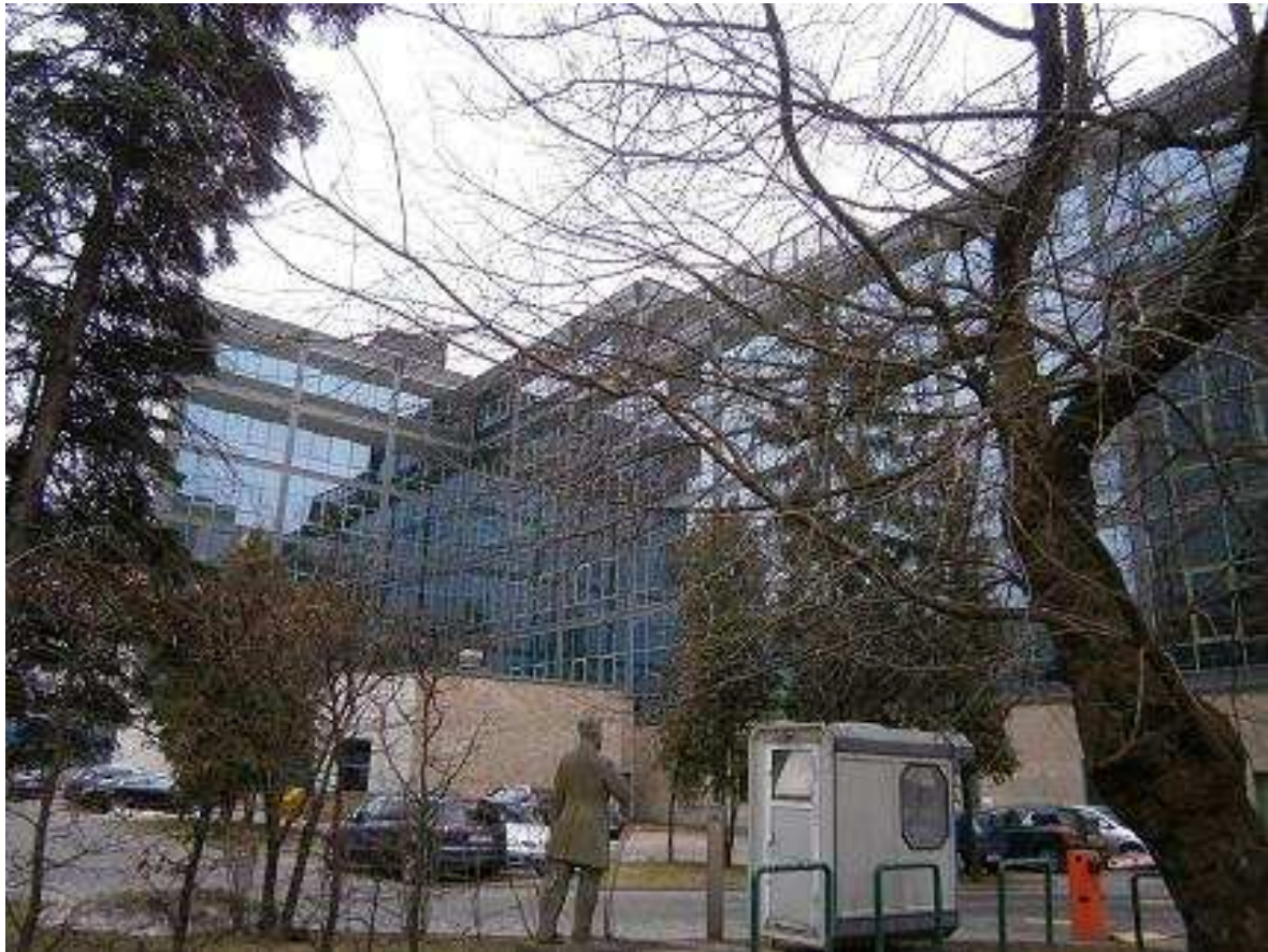
ELEWACJA OD PODWÓRZA
